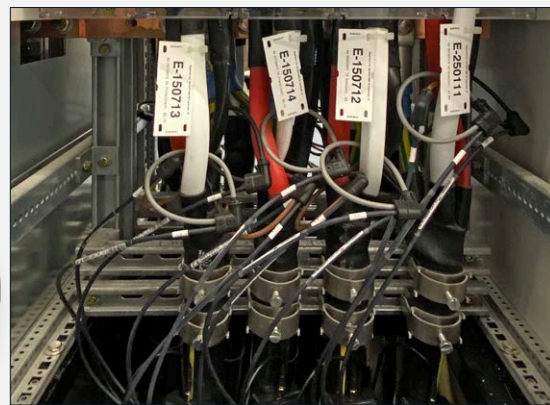
Rappresentazione dei moduli Current Link per la misurazione di curve di potenza individuali/canale
