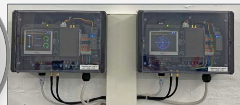
Rappresentazione dei moduli Current Link per la misurazione di curve di potenza individuali/canale
