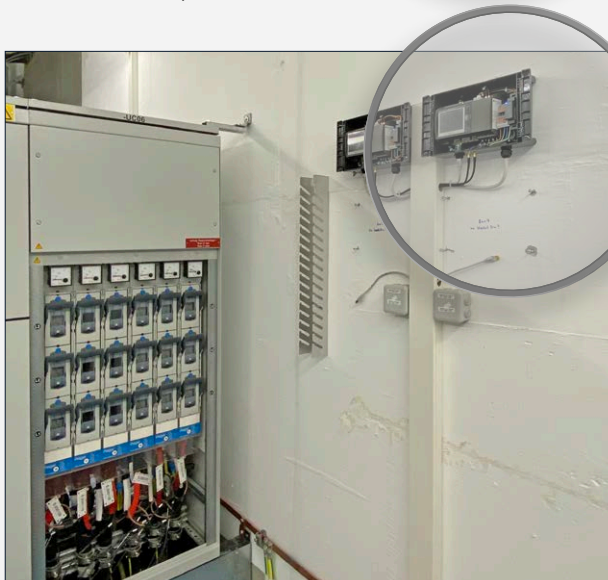
Rappresentazione del quadro di comando e del dispositivo di montaggio decentrato unità base LINAX® PQ5000CL
