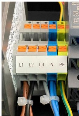
Der Anschluss erfolgt auf die Klemmen L1, L2, L3, N und PE des Klemmenblocks.
