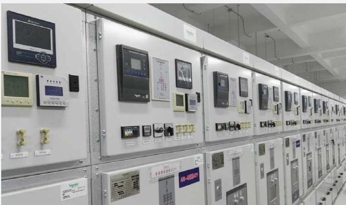
Die Energie des Rechenzentrums wird über mehr als 50 Schaltanlagenkreise im Medium- und Niederspannungsbereich unterverteilt.
