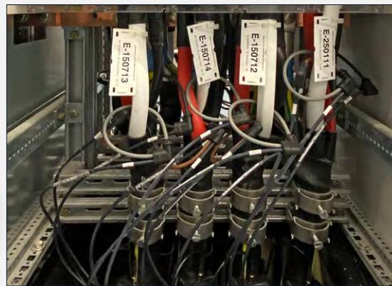
Installierte Current Link-Module pro Abgang
