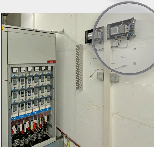
Darstellung der Schaltanlage und der dezentral montierten Basisstationen LINAX® PQ5000CL
