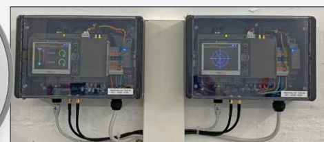
Installierte Current Link-Module pro Abgang
