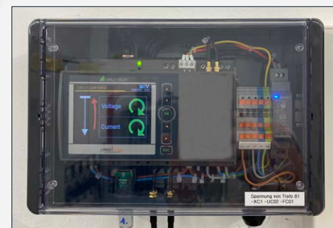
Detailansicht der dezentral montierten Basisstationen LINAX® PQ5000CL
