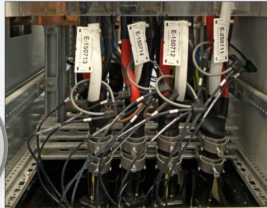
Darstellung der Current Link-Module zur individuellen Leistungsgang-Messung/Kanal
