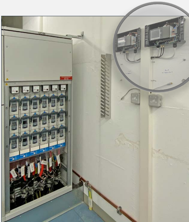
Darstellung der Schaltanlage und der dezentral montierten Basisstationen LINAX® PQ5000CL
